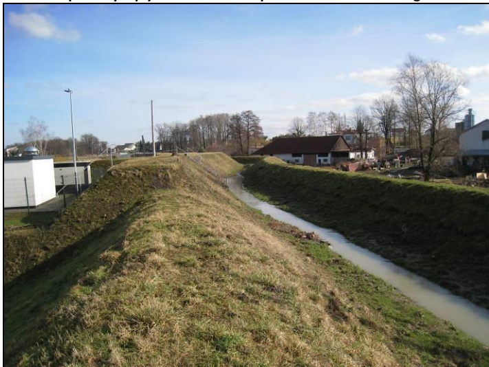
Fot. 6 Pawłówka płynąca w obwałowaniu, widok w kierunku wschodnim
